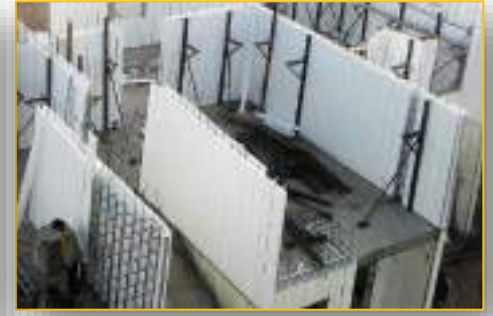
نمونه دیوار ICF در مرحله مونتاژ
