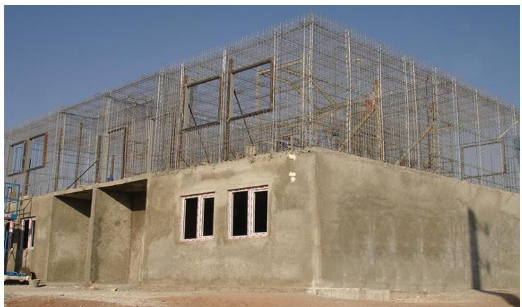
نمونه بلوک با سیستم جی-کی در فاز ۵ میسا
